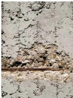
Figura 21 – Broca ou bicheira em elemento de concreto
