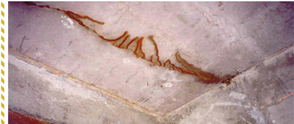
Figura 20 – Problemas na estrutura de concreto provocados por infiltrações
